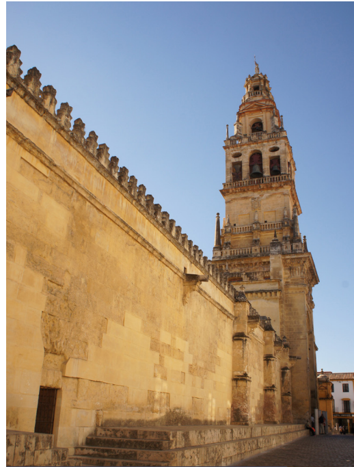
Görsel 4.3: Kurtuba Camii Minaresi
